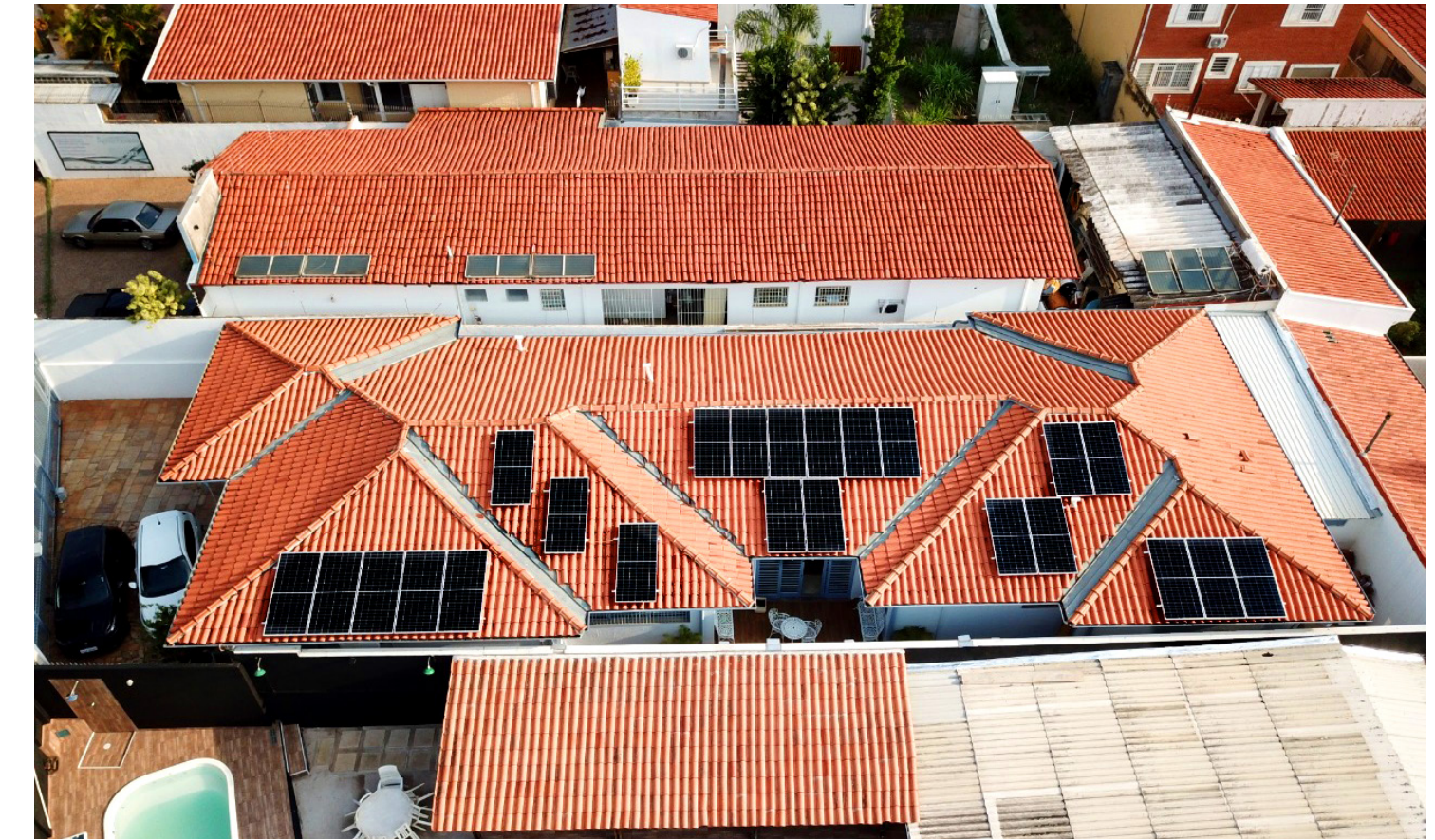
2020年，DEIF在巴西的办公室安装了光伏太阳能电池。
